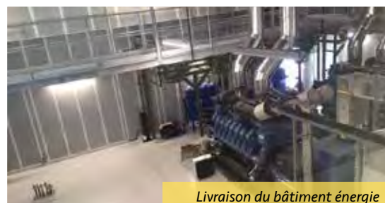
Livraison du bâtiment énergie
